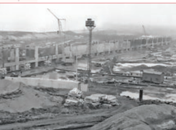
Строительство Нижнекамской ГЭС. 1960-е годы
