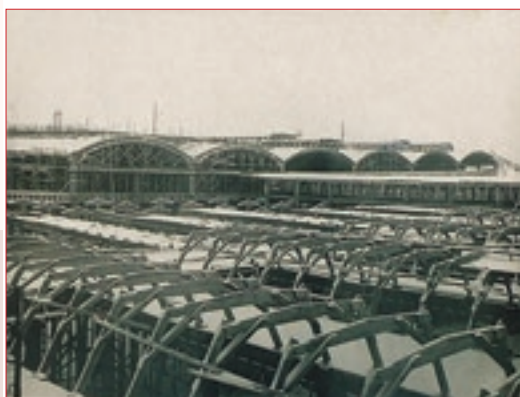
Общий вид строящихся цехов Казанского авиазавода. 1932 год
