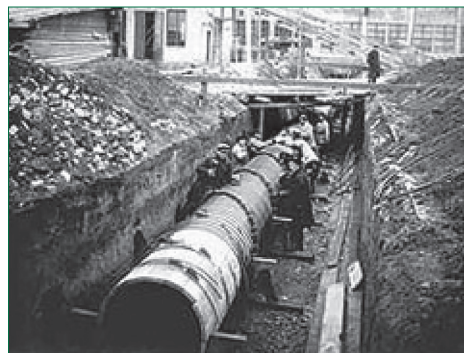
Строительство КазГРЭС. Монтаж деревянного напорного трубопровода
