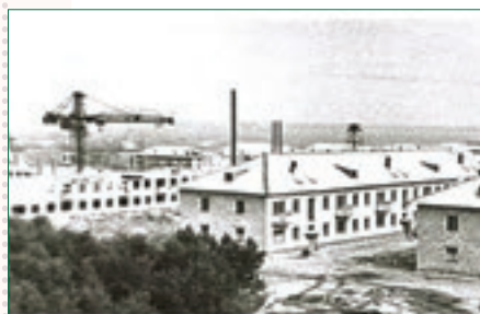
Строительство посёлка нефтяников на западной окраине Елабуги. 1959 год
