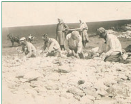
Дорожное строительство в Тетюшском районе. Середина 1930-х годов
