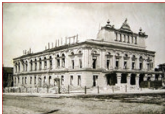
Разбор старого здания городского театра после пожара. 1925 год
